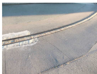
Schienen und Schräge auf dem Weg zum Eingang
